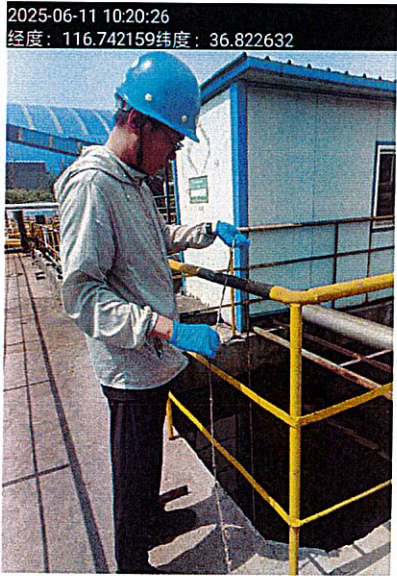
三期酚氰废水处理站清水池
